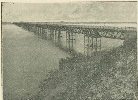
Ponte della ferrovia sul Bio-Bio presso Concezione (Chili).
